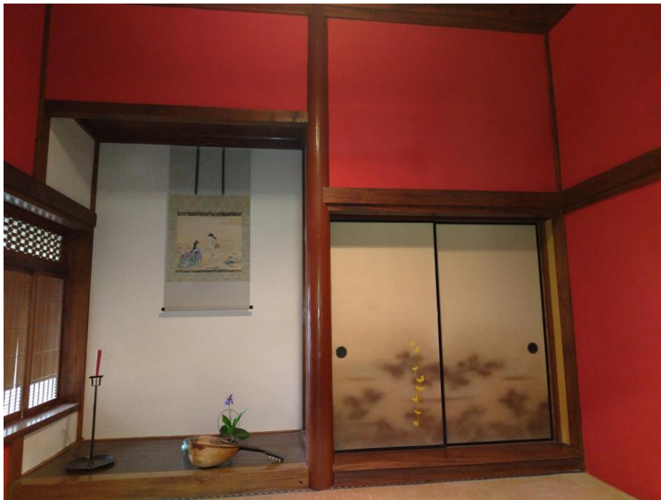
床の間と壁を耐水性膠塗料で塗装 百年の家 studio nakagami (千葉県いすみ市)
